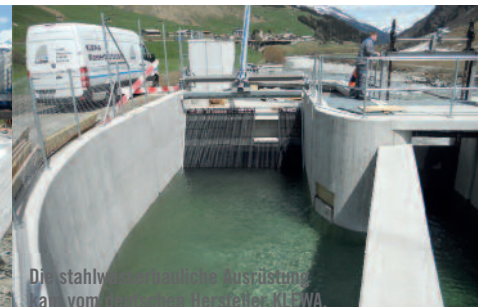
Die Arbeiten an der Fassung mit dem Sandfang sind weit gediehen.
