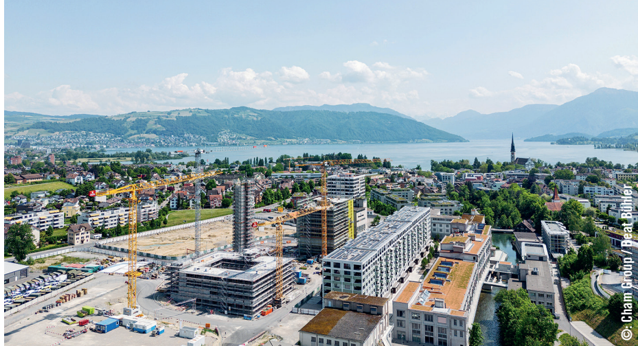
Vogelperspektive auf die Überbauung „Papieri Cham“ vom Mai 2023. Auf der rechten Bildseite befindet sich das Kraftwerk Obermühle an der Lorze.
