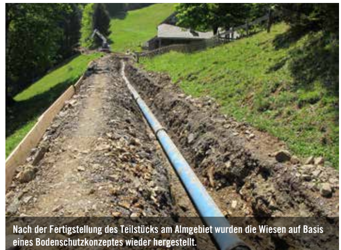
Bei der Verlegung der duktilen Gussrohre der Marke Duktus DN300 waren umfangreiche Stemmarbeiten notwendig. Die Rohre, die Brunnenstuben und die beiden Entlüftungen lieferte der Schweizer Rohrspezialist TMH Hagenbucher AG.
