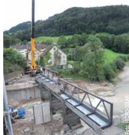
Montage der neuen Brücke über die Thur
